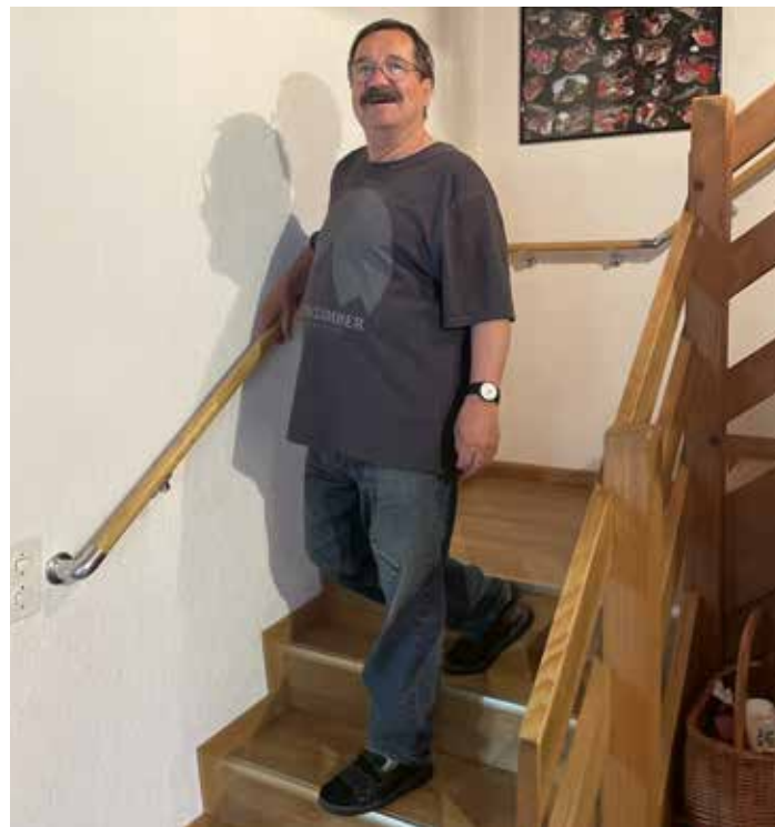
Mehr Sicherheit dank zusätzlichem, wandseitigem Handlauf
