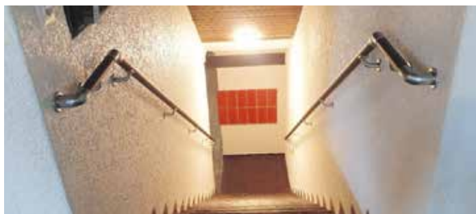
Fluchttreppen müssen immer beidseitige Handläufe haben
