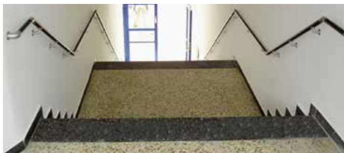
Beidseitiger Handlauf in einem Bürogebäude
