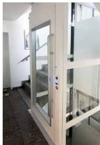
...nach dem Einbau des Liftes
