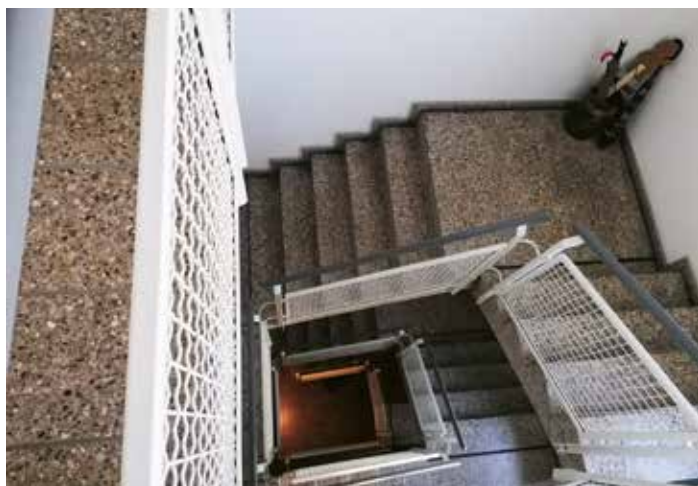
Treppenhaus vor dem Umbau
