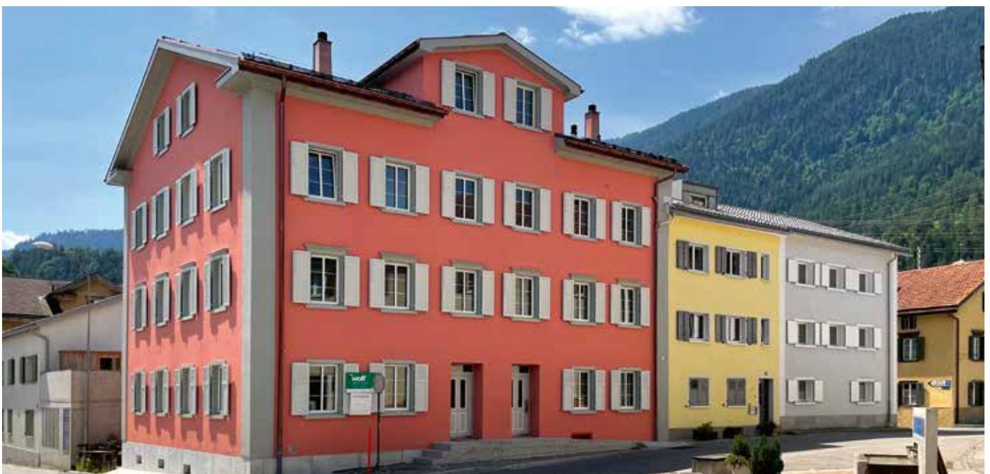
...erstrahlt nach der Sanierung in neuem Glanz.
