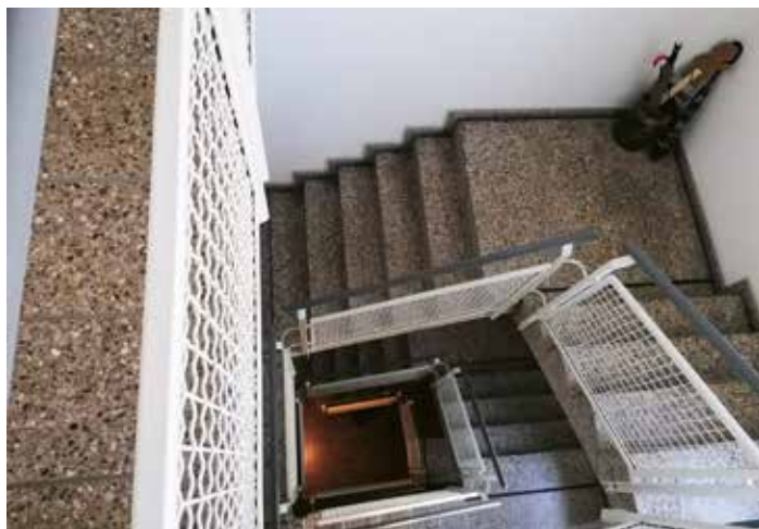
Treppenhaus vor dem Umbau
