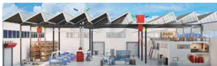
Die modularen Systeme zur Lüftung, Heizung und Kühlung bestehen aus im Raum verteilten Geräten mit bedarfsgeführter Regelung.
