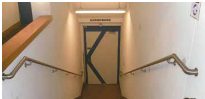
Beidseitige Handläufe beim Abgang einer Arzt-Praxis
