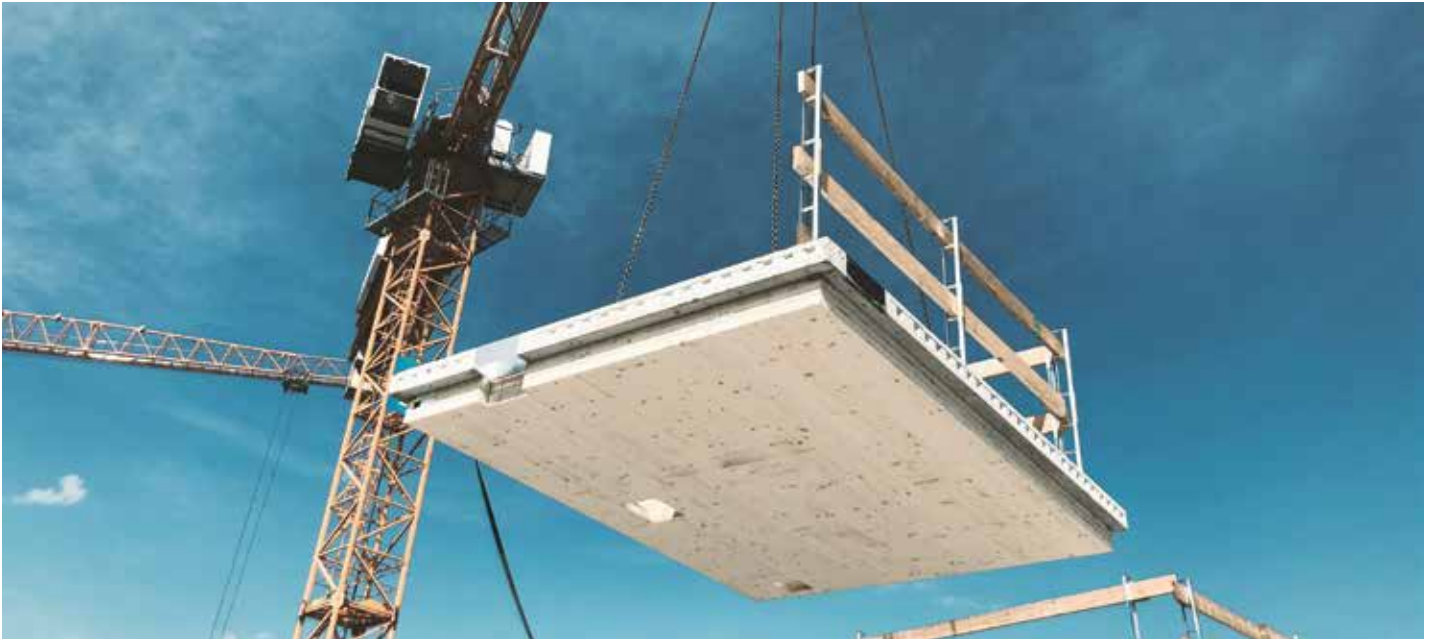
Montage einer HBV-Decke bei der Überbauung Waldhof in Rotkreuz. BILD: RENGGLI AG, SCHÖTZ
