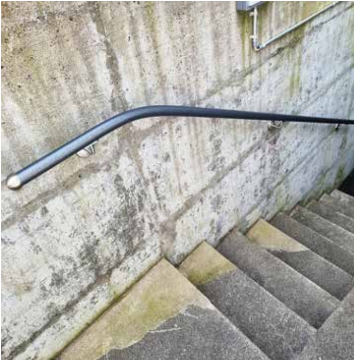
Handlauf bei einem Treppenabgang zur Tiefgarage
