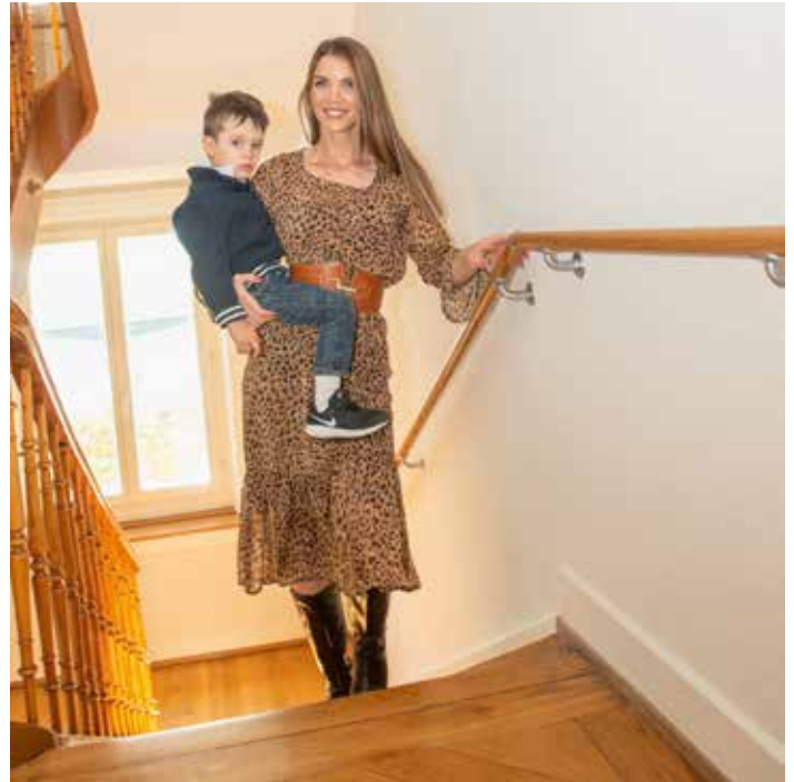
Mehr Sicherheit dank zusätzlichem, wandseitigem Handlauf
