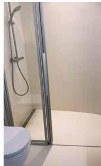
Endlich keine zu reinigenden Fugen mehr in den Nasszellen: Alsan PuraFloor, auch Wandbeschichtungen möglich.
