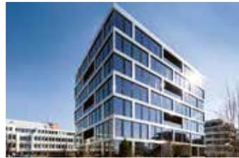
Die Fassade des siebenstöckigen Alpha Buildings in Baar ZG setzt sich aus dynamischen Sonnenschutzgläsern zusammen. Die Glastechnologie SageGlass von Saint Gobain gewährleistet den Schutz. Dank elektrischer Steuerung der Tönung ist im Sommer das Innere vor unnötiger Erhitzung geschützt. Im Winter hingegen wird die Wärme der Sonne zur Raumtemperierung genutzt. Auch bei dunkler Tönung bleiben die Fenster transparent. Die Aepli Metallbau AG produzierte und montierte die Verglasung.
