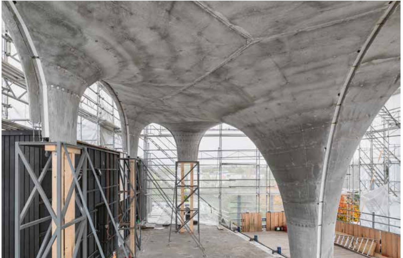
HiLo Construction: Die fertige doppelt-gekrümmte Dachschale. BILD: ROMAN KELLER
