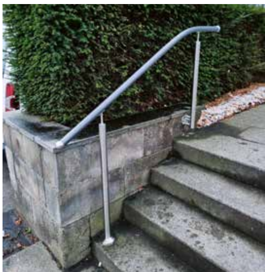
Normgerechter Handlauf bei einem Wohnblock in Winterthur
