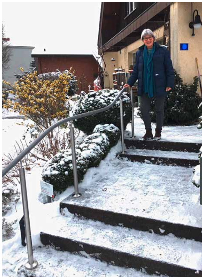
Im Winter ist das Sturzrisiko auf Aussentreppen besonders hoch!
