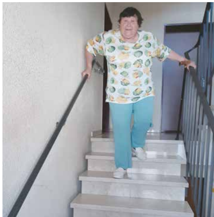
Mehr Sicherheit dank zusätzlichem, wandseitigem Handlauf
