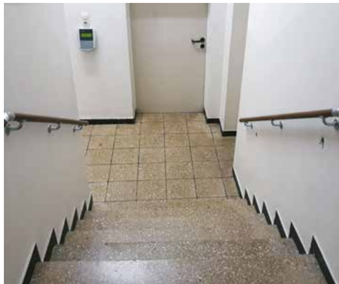
Beidseitiger Handlauf in einer Wohnanlage
