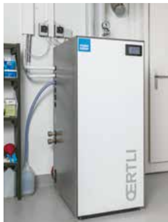
Die Split-Luft-Wasser-Wärmepumpe Oertli M Flex S macht auch im Inneren einen kompakten und aufgeräumten Eindruck.
