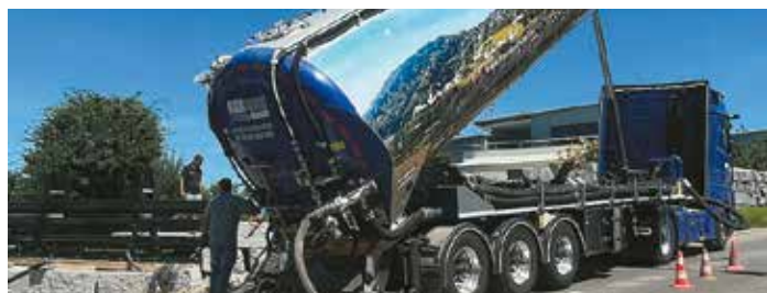
Befüllung eines «naturawall» mit hochwertigem Substrat. Zeitsparender Arbeitsablauf dank Einblas-Verfahren.
