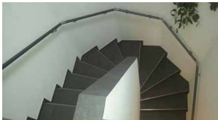
Handlauf an einer Mehreck-Treppe
