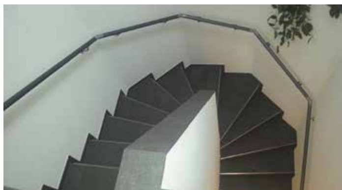
Handlauf an einer Mehreck-Treppe
