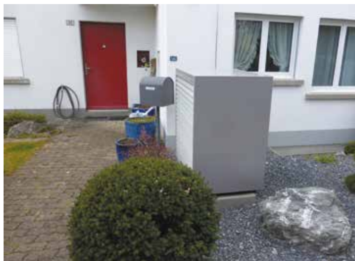
Das Aussengerät mit innovativem Eulenflügel-Ventilator zählt zu den leisesten Geräten am Markt. Daher eignete es sich vortrefflich für den Einsatz in der Volketswiler Wohnüberbauung.
