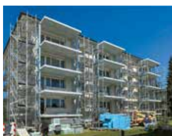
Gebäudemodernisierung in Zuzwil: Das MFH wird energetisch saniert. Dazu gehört auch, dass Wärmebrücken eliminiert und neue Balkone angebaut werden.
