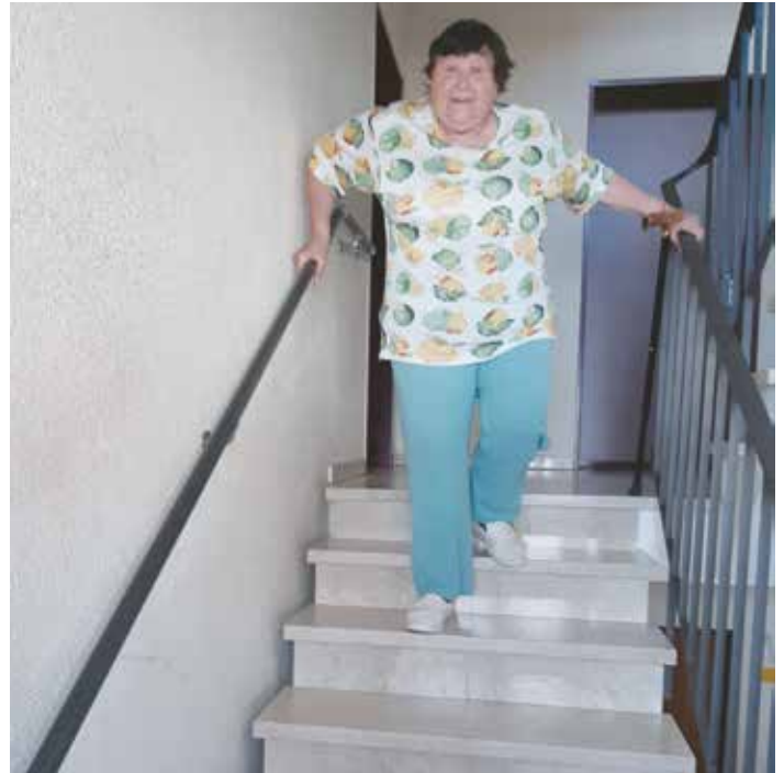
Mehr Sicherheit dank zusätzlichem, wandseitigem Handlauf
