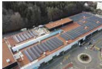
Mit der neuen Photovoltaikanlage auf dem Dach des Einkaufszentrums Fribourg Süd in Villars-sur-Glâne baut Coop die Gesamtfläche zur Gewinnung von Solarstrom auf rund 115 000 m<sup>2</sup> aus. Die Anlage in Villars-sur-Glâne ist mit rund 4300 m<sup>2</sup> eine der grössten von Coop. Rund 90% des produzierten Stroms wird am Standort genutzt. Coop erzeugt mit seinen Anlagen rund 19 Mio. kWh Solarstrom pro Jahr. Dies entspricht dem jährlichen Stromverbrauch von rund 5800 Schweizer Haushalten.
