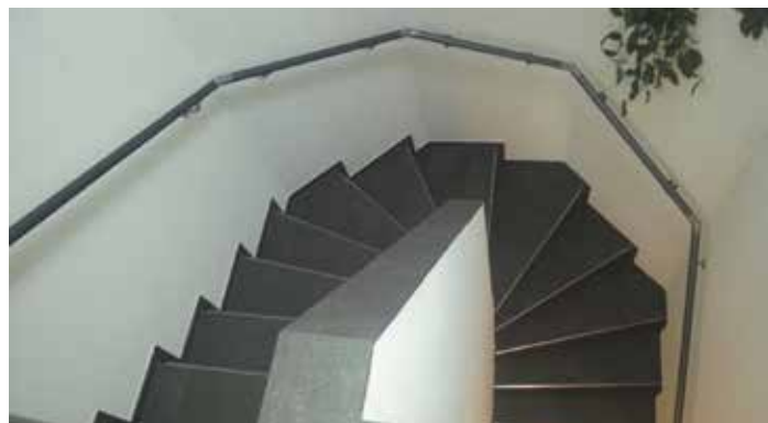
Handlauf an einer Mehreck-Treppe.
