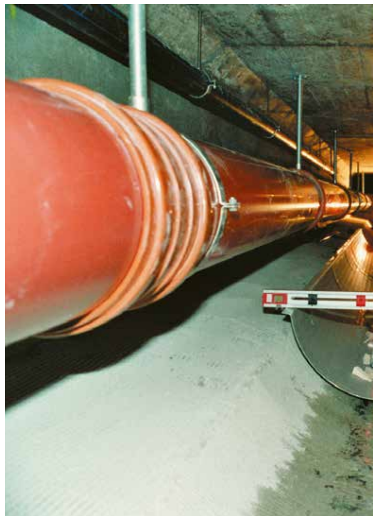
Der Einbau des Wärmetauschers in der Abwasserkanalisation. © Stadtwerk Winterthur
