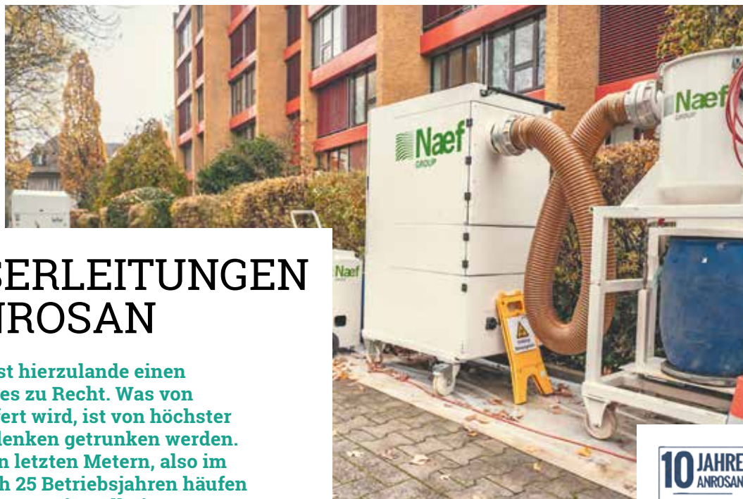
Sanierung der Trinkwasserleitungen eines Mehrfamilienhauses. Ohne Epoxidharz.
