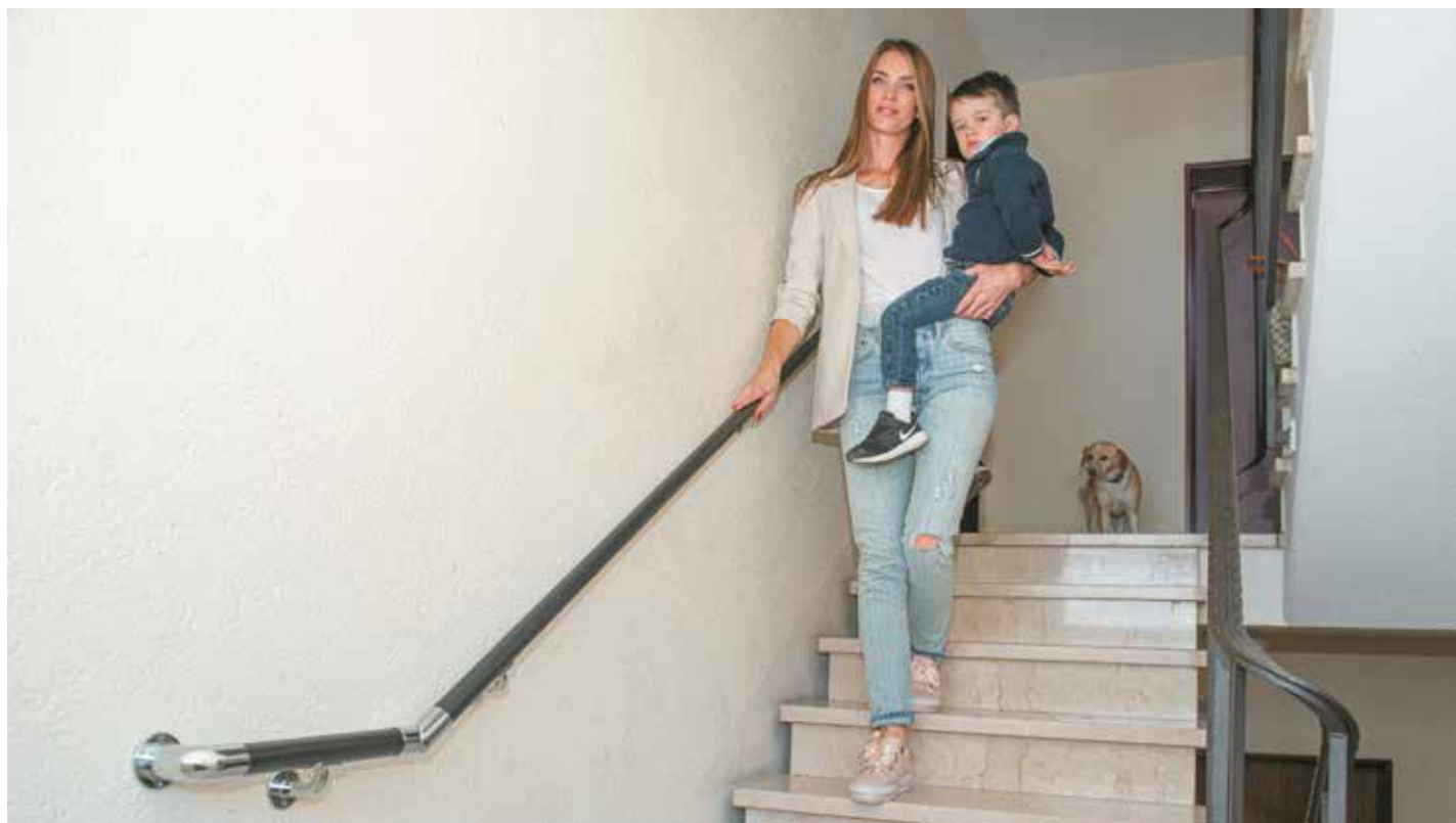
Zusätzlicher, wandseitiger Handlauf für mehr Sicherheit!
