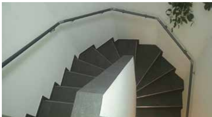
Handlauf an einer Mehreck-Treppe
