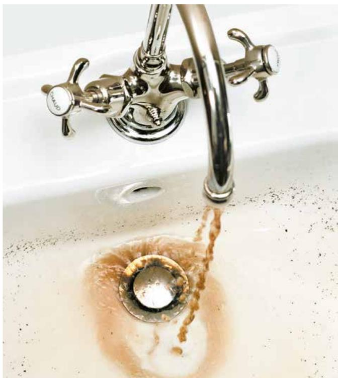
Rostwasser im Lavabo deutet auf die Alterung der Trinkwasserinstallation hin.
