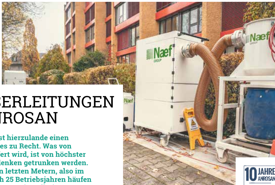
Sanierung der Trinkwasserleitungen eines Mehrfamilienhauses. Ohne Epoxidharz.
