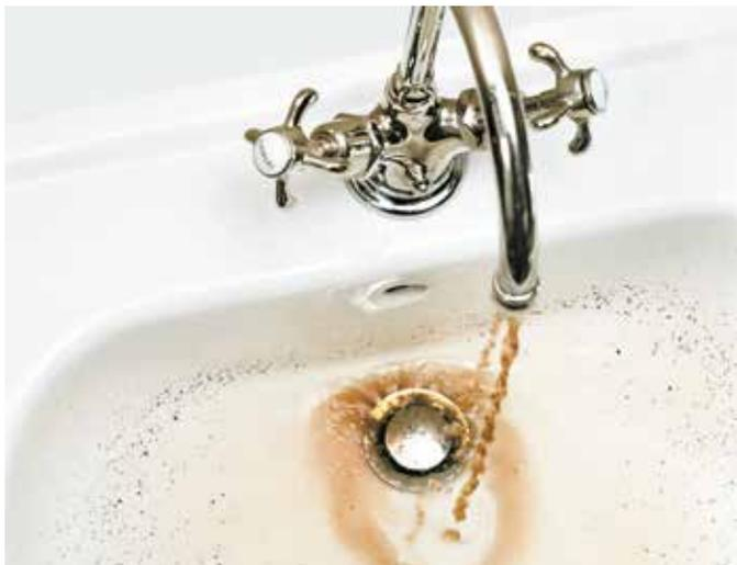
Rostwasser im Lavabo deutet auf die Alterung der Trinkwasserinstallation hin.
