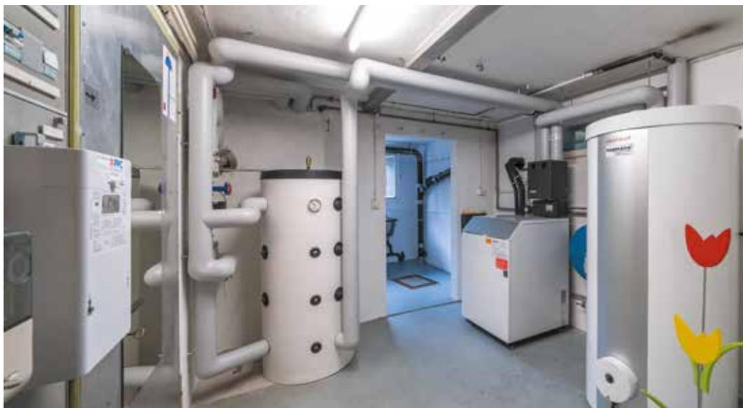
Hinten das Innengerät der Weishaupt-WP, rechts der Boiler, links der Wärmespeicher
