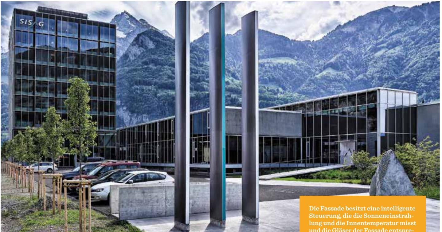
Die Fassade besitzt eine intelligente Steuerung, die die Sonneneinstrahlung und die Innentemperatur misst und die Gläser der Fassade entsprechend einstellt.
