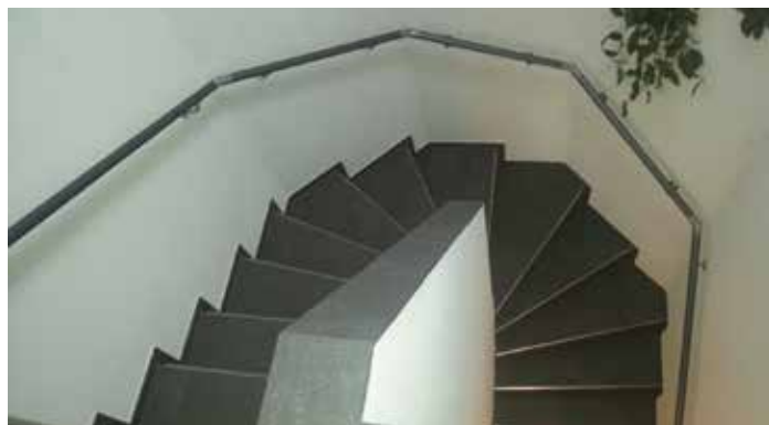
Handlauf an einer Mehreck-Treppe
