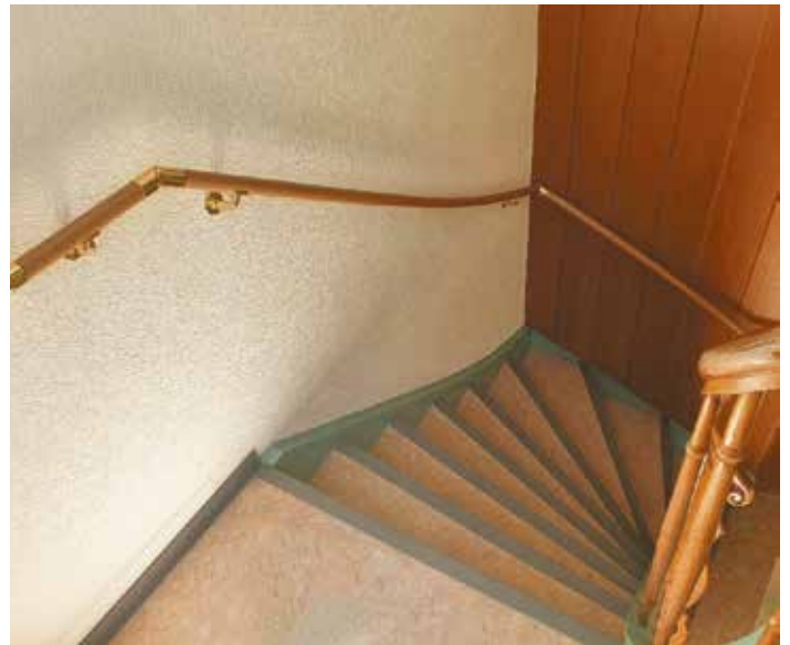
wandseitiger Handlauf, dort wo die Stufen breiter sind
