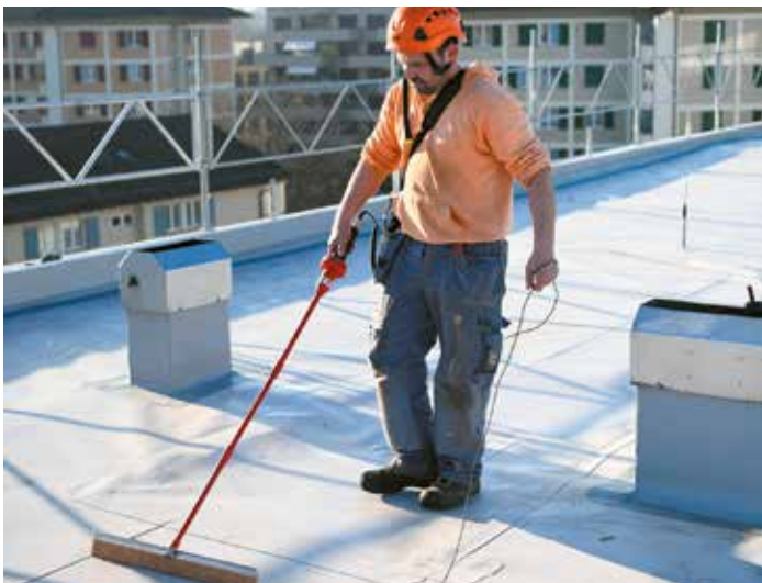
Die Hochvolt-Prüfung des nackten Daches kann durch den Verleger vorgenommen werden, während die Niedervolt-Prüfung (welche bei Dächern mit Nutzschicht nötig ist) von einer erfahrenen Fachperson durchgeführt werden muss.
