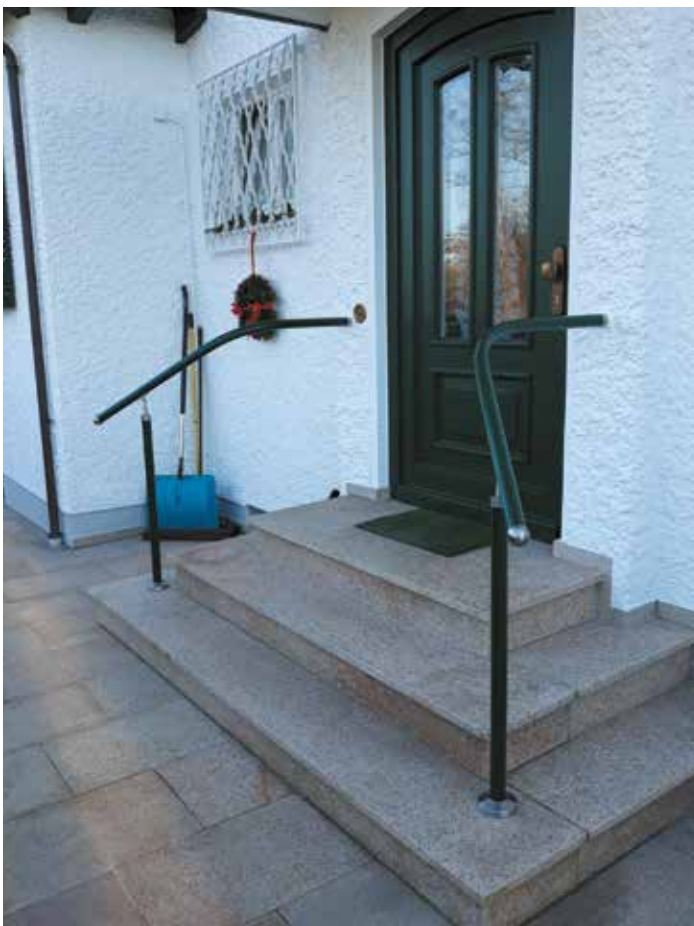
Beidseitiger Handlauf mit grünen Stützen
