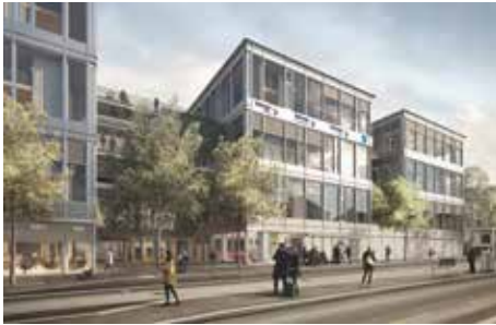
Büroneubau Yond: intelligente Reinigungsintervalle.
