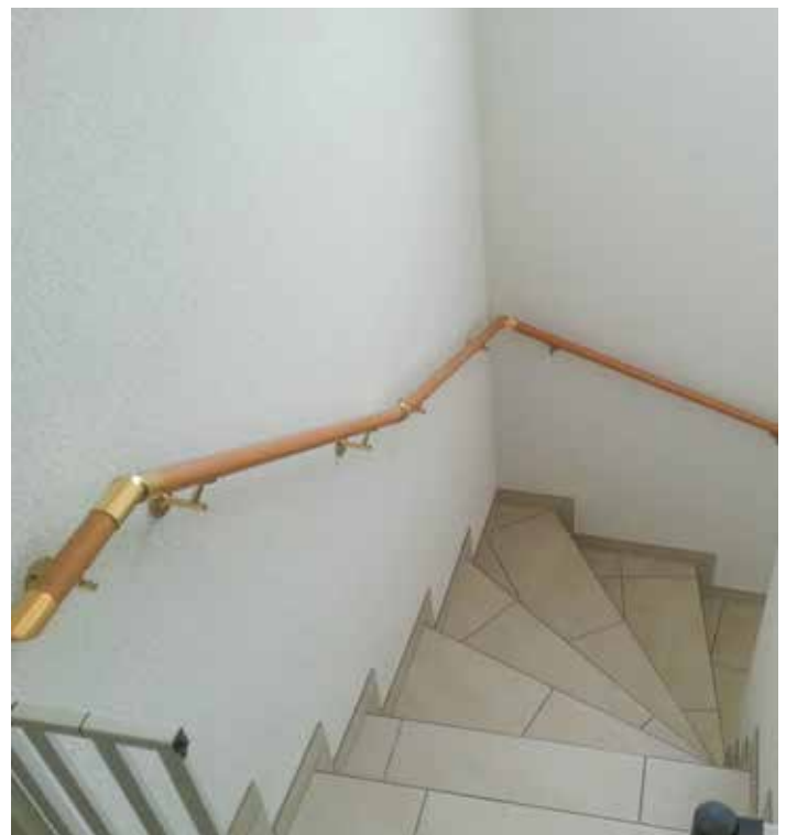
Handlauf in Buche, wandseitig, wo die Stufen breiter und damit sicherer sind
