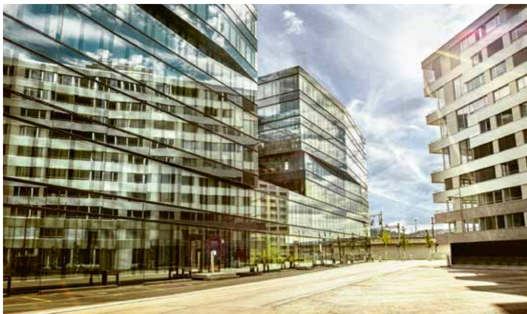
Die 200 Kommunikationsnetze von SUISSEDIGITAL leisten einen wichtigen Beitrag zur Grundversorgung mit hochleistungsfähigem Breitbandinternet in städtischen Gebieten ...
