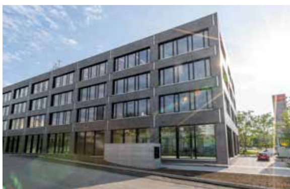
Neues Büro- und Gewerbehäus «Hangaar» in Aarau mit geschliffenen Fassadenelementen aus Terrazzo-Beton. (BILD: CREABETON AG)
