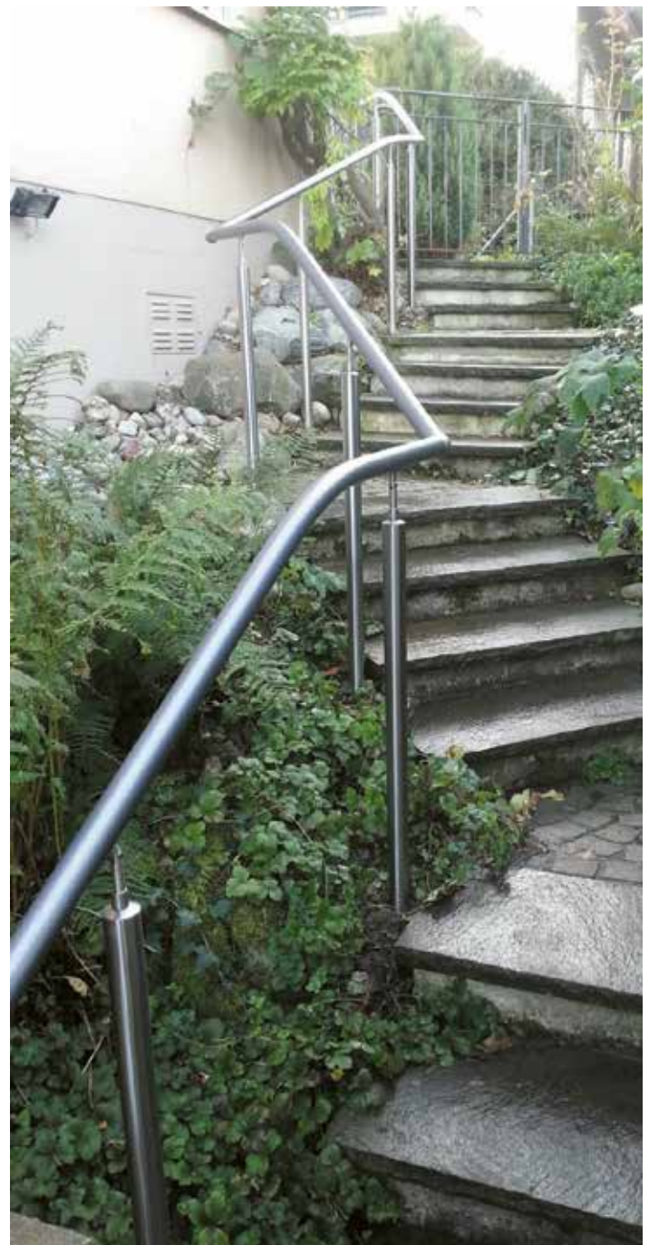
Durchlaufender Handlauf an einer nicht einfachen Treppenanlage
