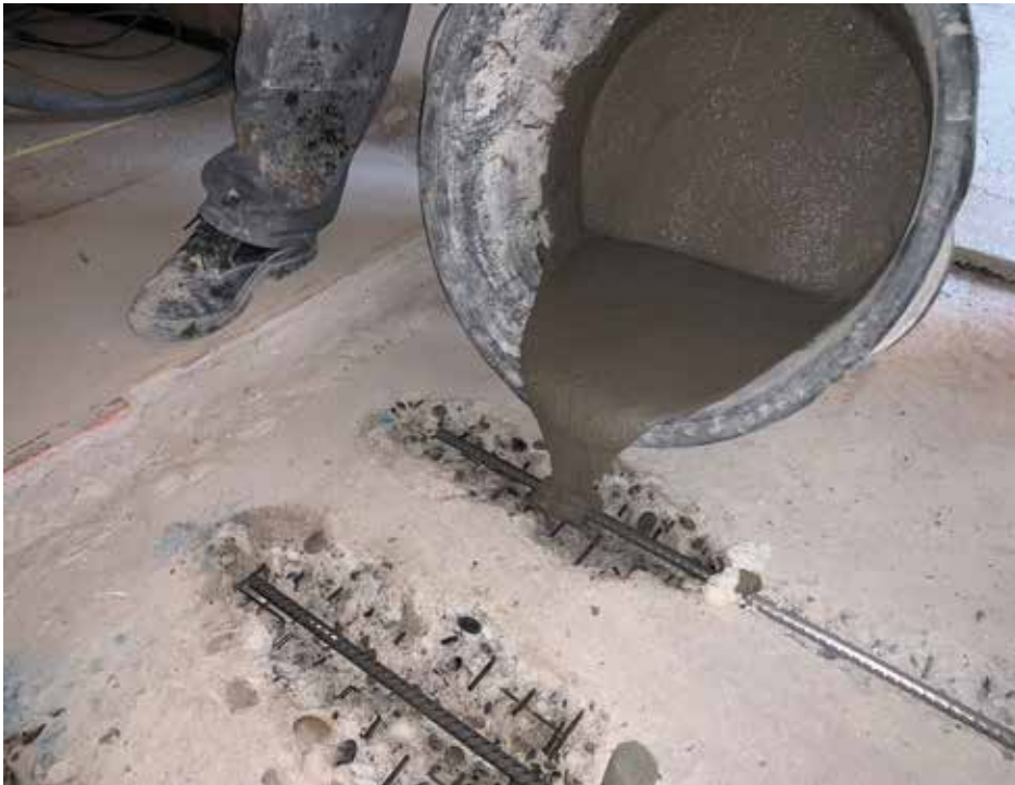
Eingießen von Vergussmörtel in vorgefräste Schlitznuten.
