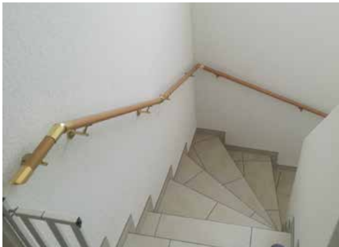
Handlauf in Buche, wandseitig, wo die Stufen breiter und damit sicherer sind
