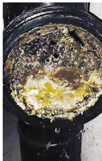
Fett, eine Portion Essensreste und Kalk haben sich im Spülstutzen eines Küchenfallstrangs abgelagert.
