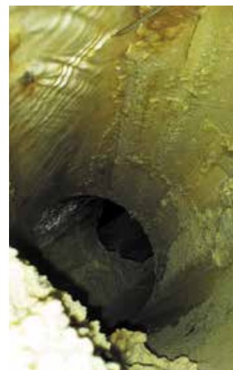
Ein stark verschmutzter Terrassenablauf ist nach Wartungsarbeiten wieder funktionstüchtig.
