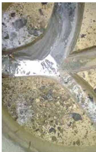
Blick in einen Kontrollschacht, in den drei Rohre münden.
