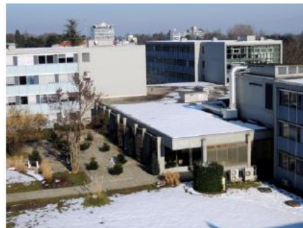
JONCTION DU BÂTIMENT CENTRAL AUX TROIS AILES DE BUREAUX
