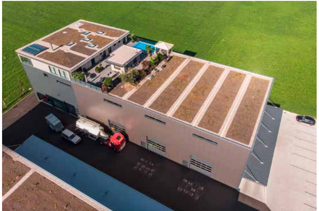
SikaRoof AT – EINE Bahn für alle Aufbauten (begrünt, bekiest, begebar, nackt)
