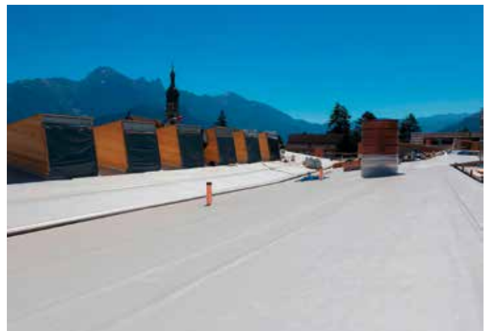
SikaRoof AT - Die TPO Abdichtung der neusten Generation bleibt auch bei kalten Jahreszeiten flexibel und dichtet Dachflächen sicher ab.
