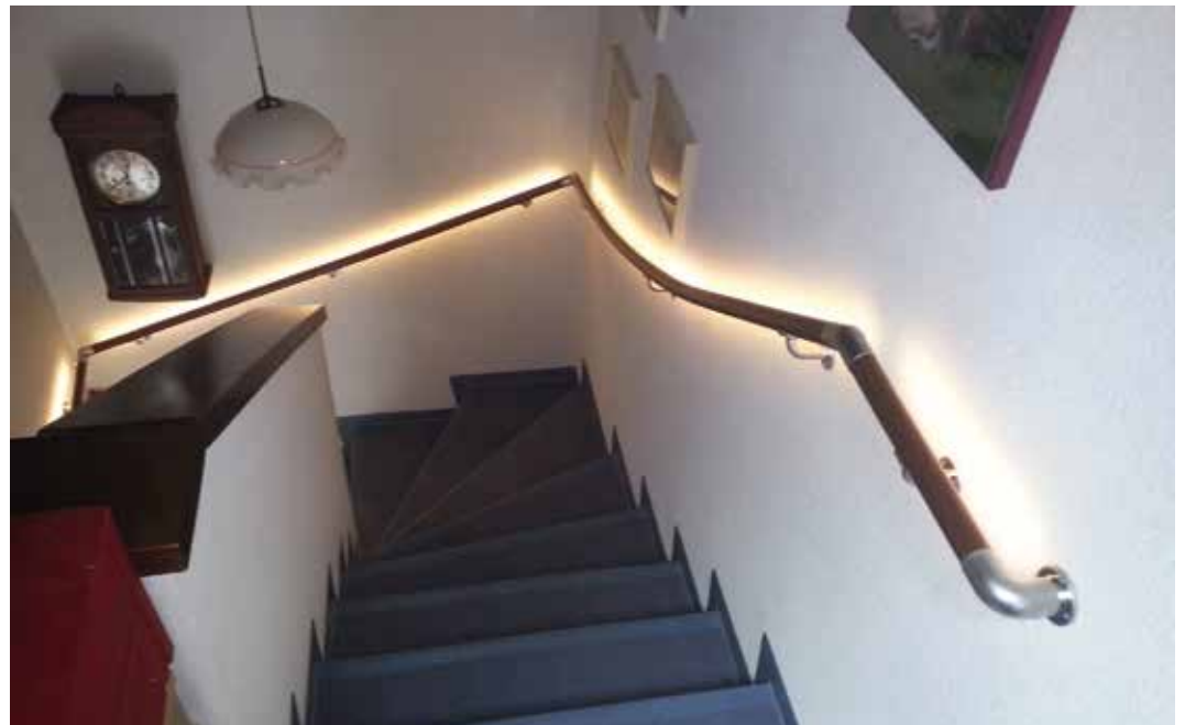
geschwungener Handlauf mit durchlaufendem Licht, in den Ecken durchlaufend
