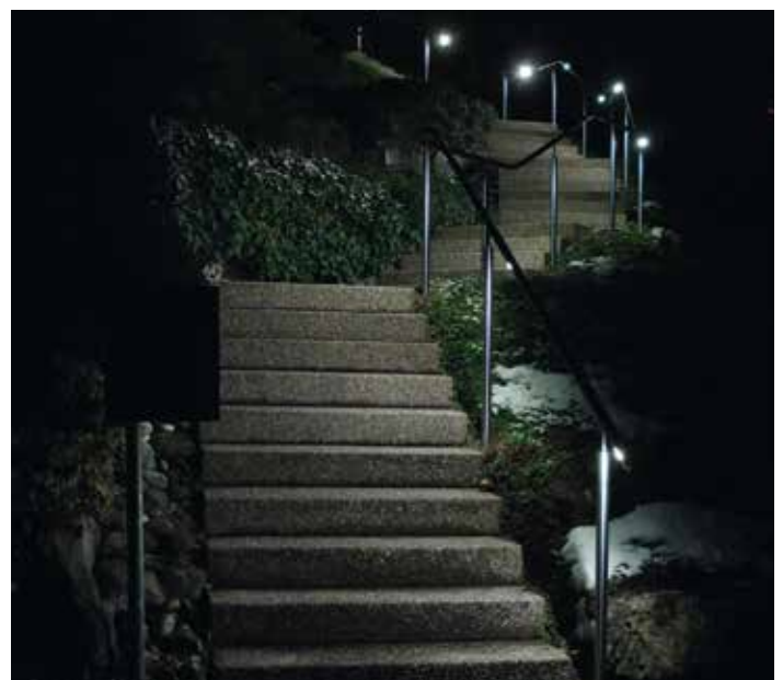
Aussenhandlauf mit punktuelltem Licht
