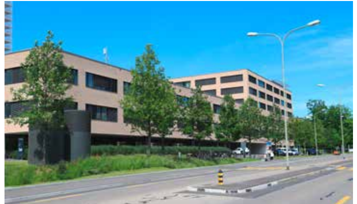
Der Neubau des Spitals hat bis zu sechs Geschosse.
