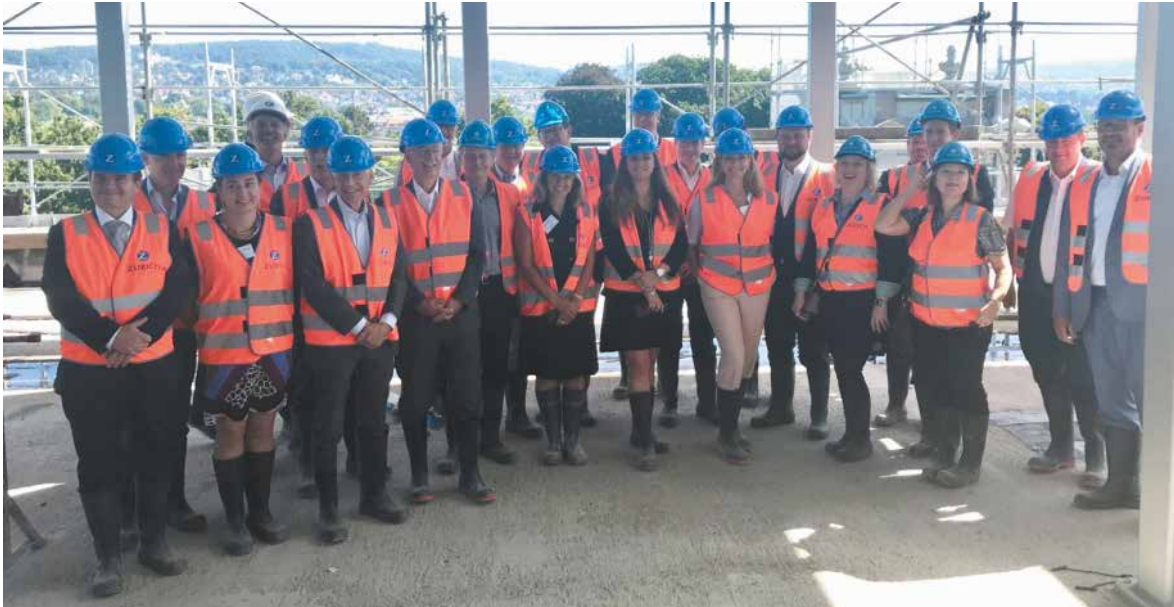
Mitglieder des Verbands Fiabci-Suisse auf der obersten Etage im Rohbau des künftigen «Quai Zurich».
