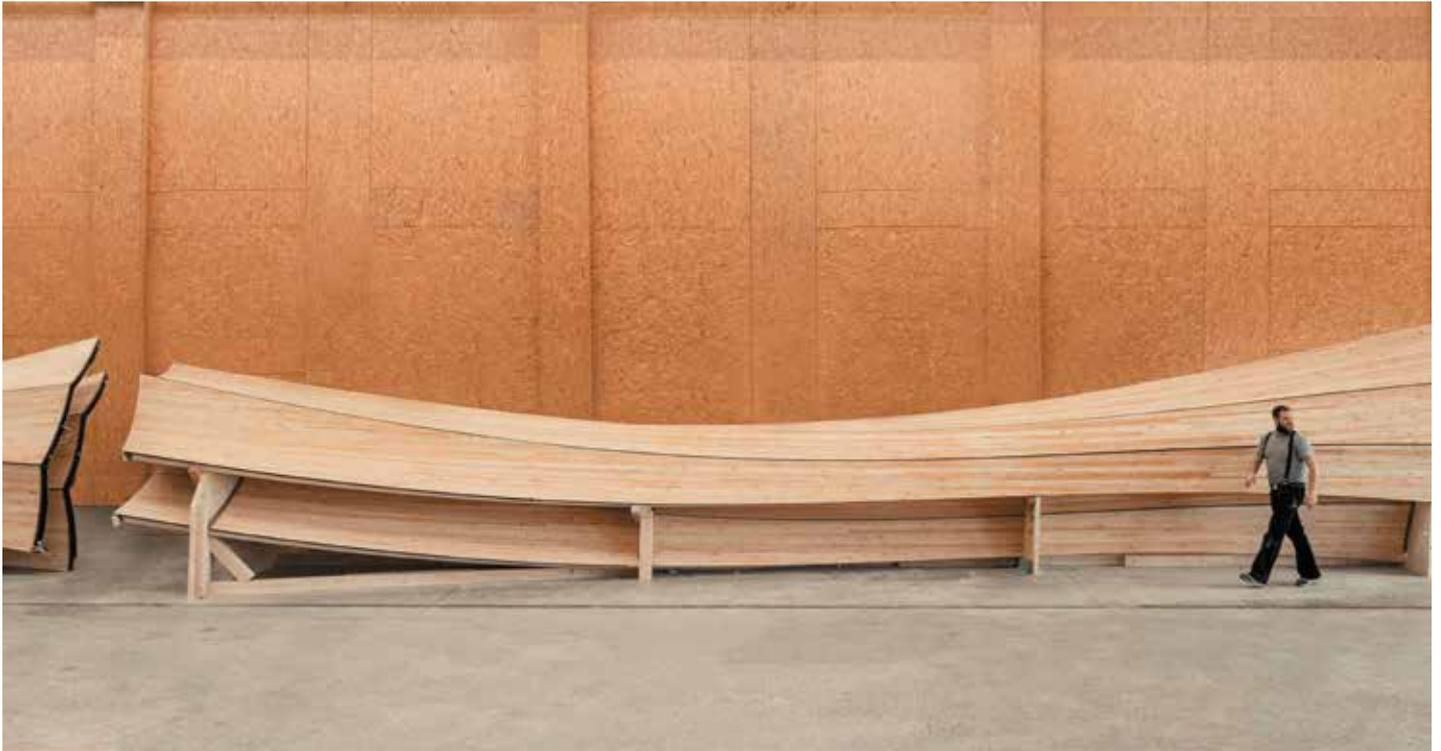
ser von 4 Metern, verengt sich in der Mitte auf 1,6 Meter und öffnet sich nach oben auf 3 Meter. Die selbstformenden Komponenten bestehen aus regional bezogenen Schweizer Fichtenholzbrettern. Die einzelnen Bauteile beziehungsweise Paneele haben eine Länge von bis zu 15 Metern, mit einem Radius von 2,4 Metern und einer Dicke von nur 9 Zentimetern.
