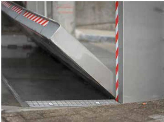
Klappschott schützt Zugänge oder Zufahrten vor Hochwasser – dank automatischem, mechanischem Schliessmechanismus auch bei bestehenden Gebäuden eine zuverlässige Massnahme. (Foto: VKG)
