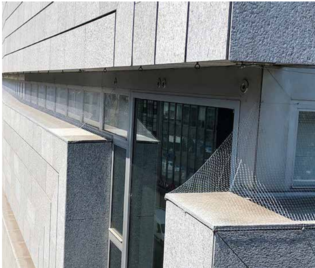
Von blosserem Auge kaum sichtbar: die Taubenabwehr von Mauerwerken, hier die Vernetzung eines Geschäftshauses. Das Netzmaterial ist transparent, UV-lichtgeschützt und wetterfest.
