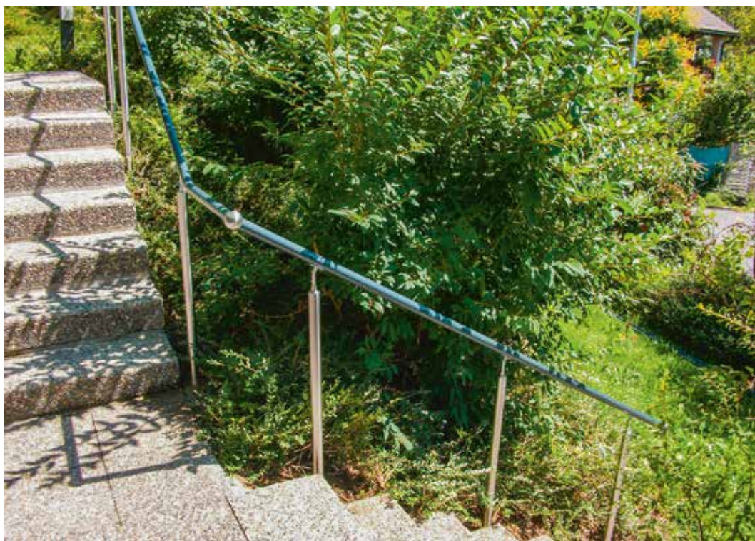
Aussenhandlauf mit einbetonierten Stützen in Chromstahl, Handlauf in Alu mit Laminat im Dekor Grün
