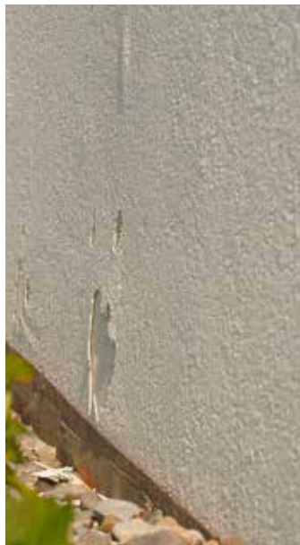
Die Sanierung von Hagelschäden wie aufgeplatzte Fassaden ist oft sehr kostspielig.
