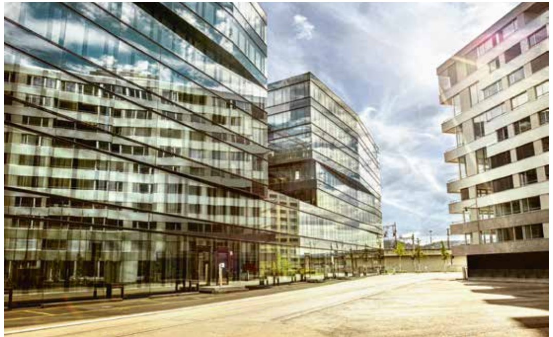
Die 200 Kommunikationsnetze von SUISSEDIGITAL leisten einen wichtigen Beitrag zur Grundversorgung mit hochleistungsfähigem Breitbandinternet in städtischen Gebieten ...
