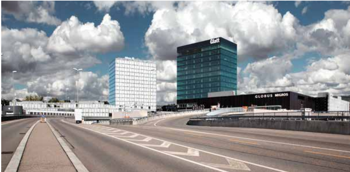
Die fertiggestellte neue Fassade des Glatt Towers (bezugsbereit im Oktober). (BILD: LIB AG)
