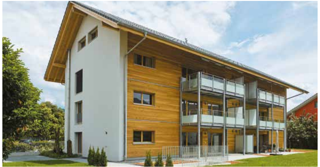
Das vorspringende Satteldach schützt die Fassade vor Witterungseinflüssen.
