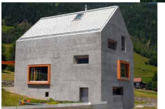
Das fünfeckige Haus hat gegossene, monolithische Aussenwände aus Dämmbeton. (BILD: ZVG)
