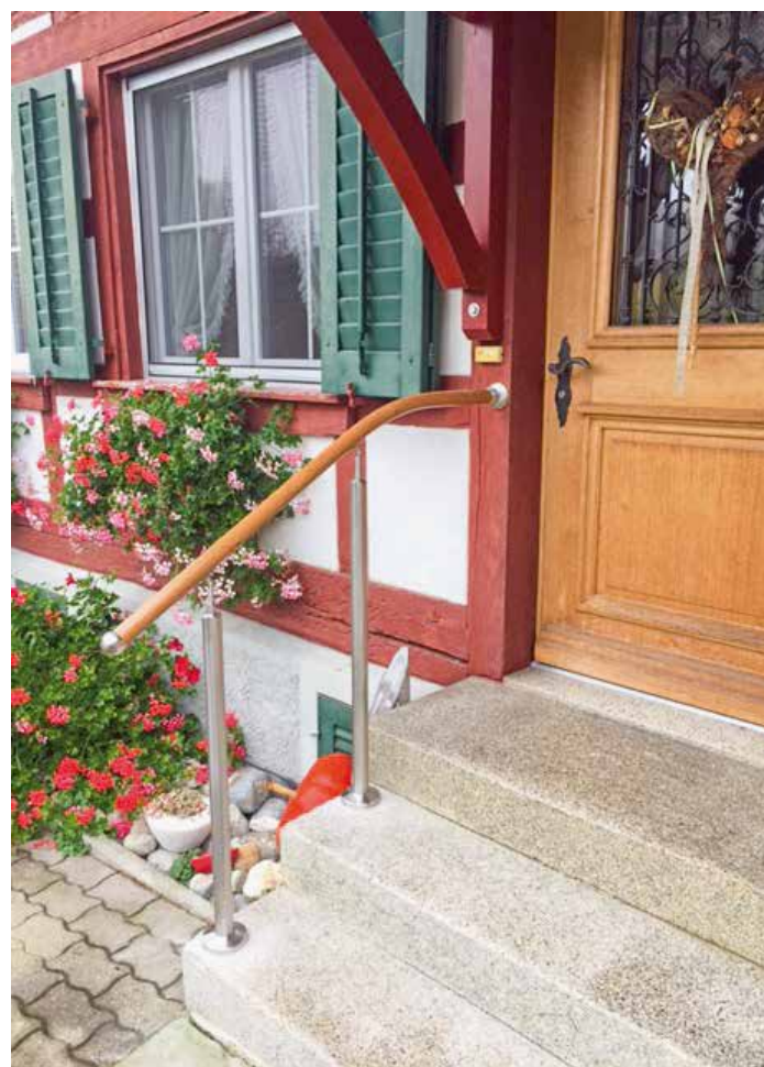
Kleiner Aussenhandlauf mit aufgeschraubten Stützen
