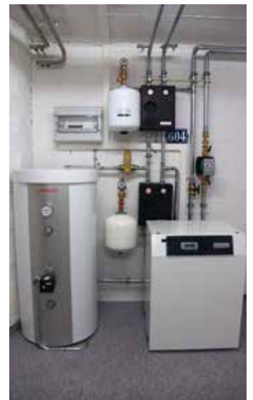
Weishaupt Sole/Wasser-Wärmepumpe WWP S 8 ID (Sole/Wasser) mit einer Wärmeleistung von 8,1 kW und einem 200 l Energiespeicher WES 200 Eco/WP.
