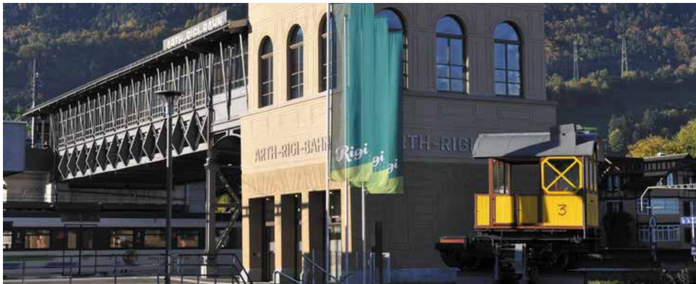
Der renovierte Hochperron mit dem neuen Zugangsturm sowie dem repräsentativen Führerstand des ersten Motorwagens Nr. 3 aus dem Jahr 1907 (Bild: Angelo Zoppet-Betschart).
