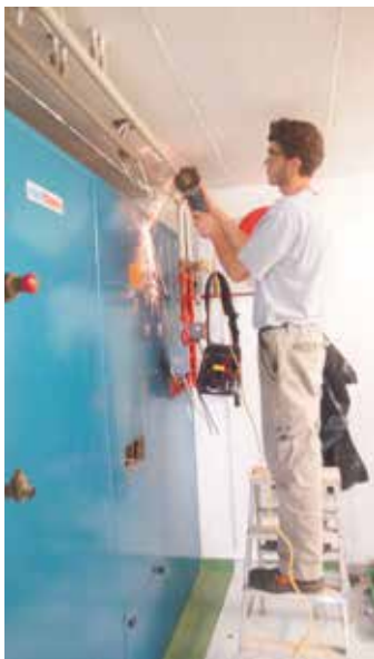
Die alte Elektrospeicher-Heizung muss raus.
