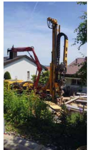
Pro Haus wird eine Erdsonden-Bohrung realisiert.
