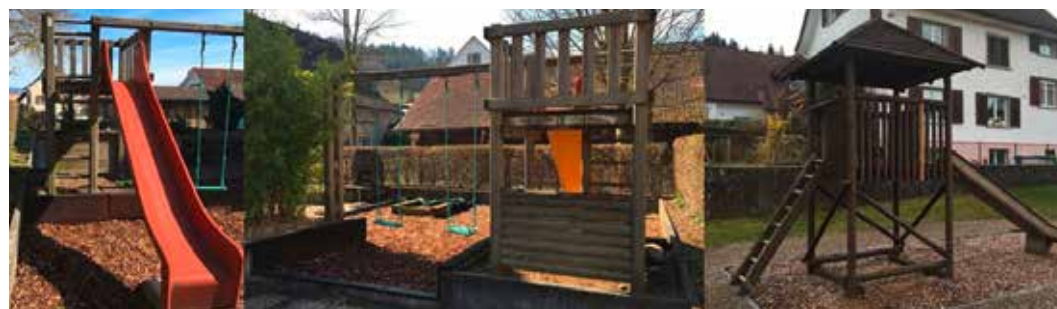
Beispiele: Fall- und Freiräume, Befestigungen entsprechen NICHT den Sicherheitsnormen
