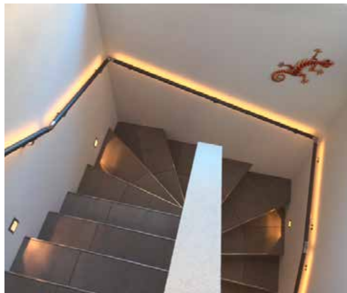
Wandseitiger Handlauf mit LED-Beleuchtung, elegant und sicher
