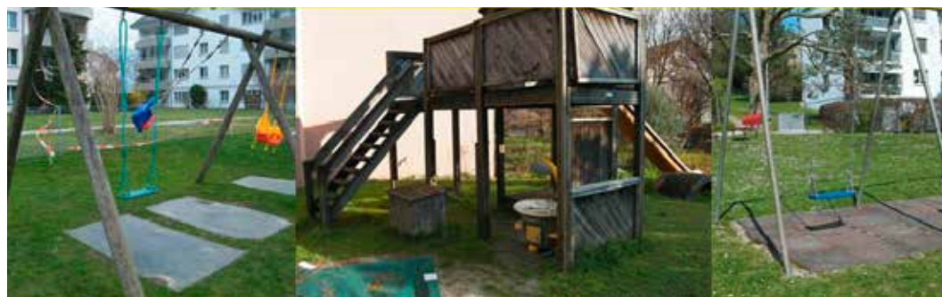
Alte, ungewartete, nicht der Norm entsprechende Spielplatzanlagen stellen ein Sicherheitsrisiko dar!
