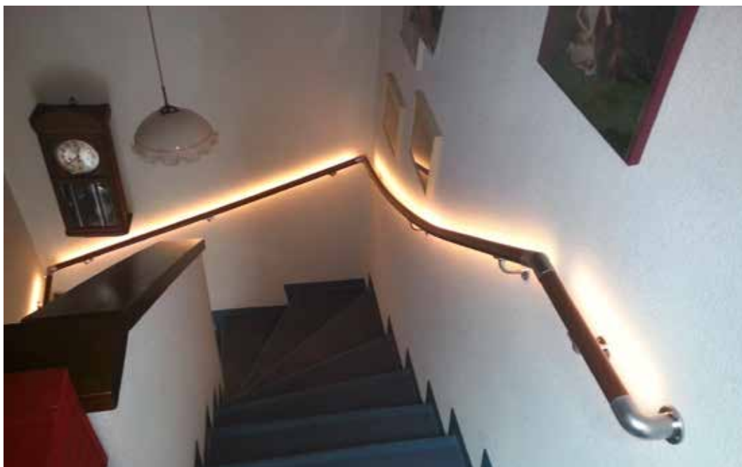
geschwungener Handlauf mit durchlaufendem Licht, in den Ecken durchlaufend
