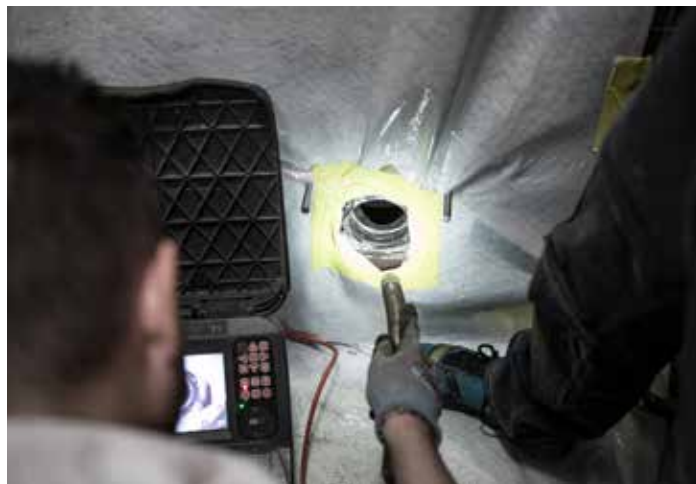
Prüfender Blick auf das Display: Mit der Kamera-LED-Lampe am Schlauchende wird jedes Abwasserleitungsproblem ausfindig gemacht. Die Aufnahmen dienen auch der Qualitätssicherung.
