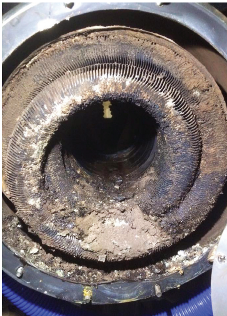
Condensatore di una caldaia alimentata con olio combustibile prima e dopo la pulizia
