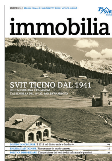
Lo stabilimento di produzione delle acque minerali di San Bernardino (foto del 1941)
